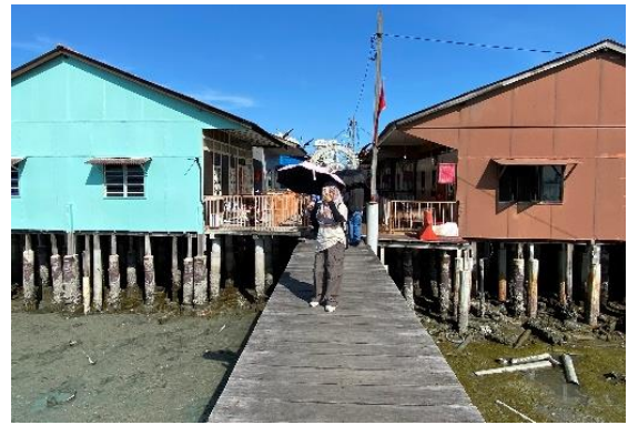
写真3 橋李姓の栈橋
